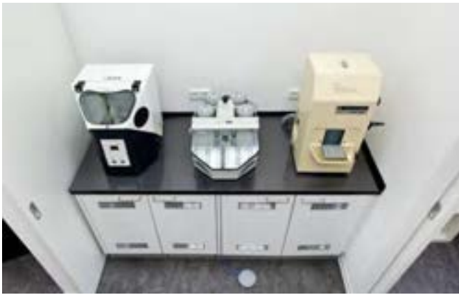
Unterschränke mit Lüftungsgitter für Absaugung. Floor cupboards with ventilation grate.
